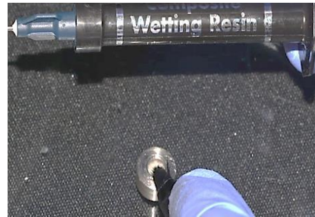
Figura 6. Aplicación de Wetting resin sobre primera capa de resina
