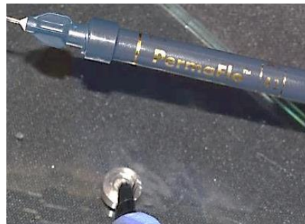
Figura 7. Aplicación de Resina fluida Permaflo sobre primera capa de resina
